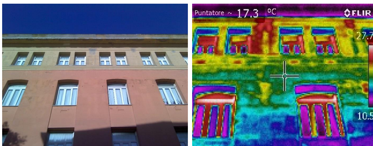
Figura 4.3 – Rilievo termografico delle pareti esterne lato ovest e interni P3.
