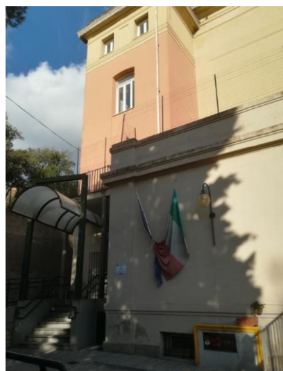
Figura 4.1 - Particolare della facciata sud-ovest con ingresso principale
