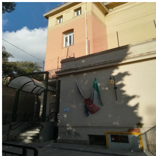
Figura 1.1 - Particolare della facciata principale esposta a sud-est
