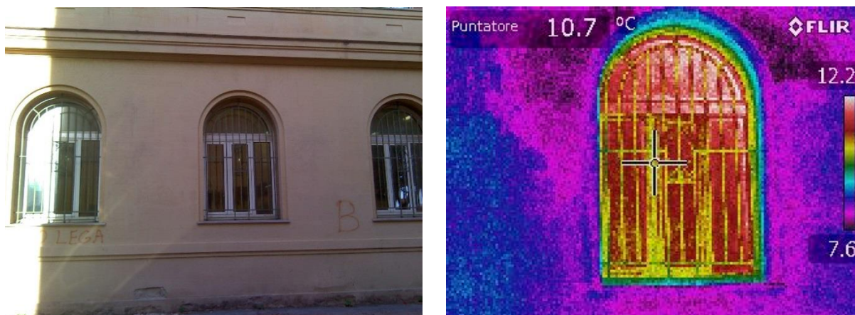
Figura 4.5 – Rilievo termografico dei serramenti
