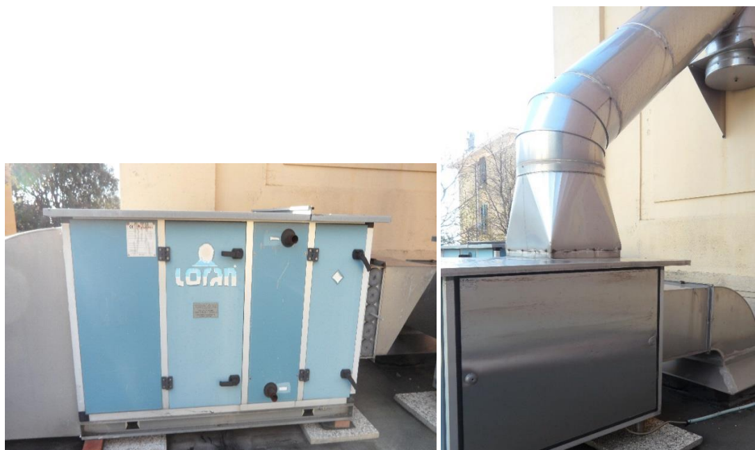
Figura 4.12 - Sistema di ventilazione meccanica unità di immissione e unità di estrazione.
